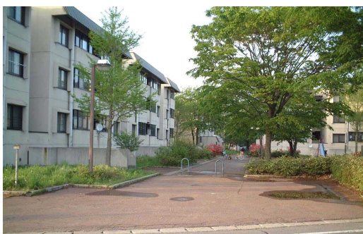
県営獅子ヶ森住宅 街路
